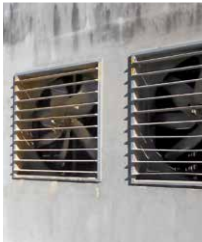
Wentylatory to główny element tzw. wentylacji mechanicznej. Wymuszają one ruch powietrza w pomieszczeniu.
